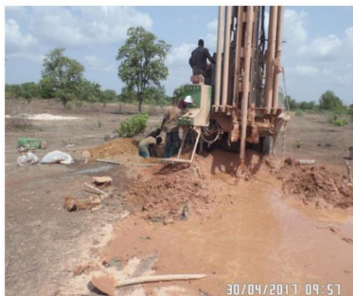
Installation pour le forage F 2
