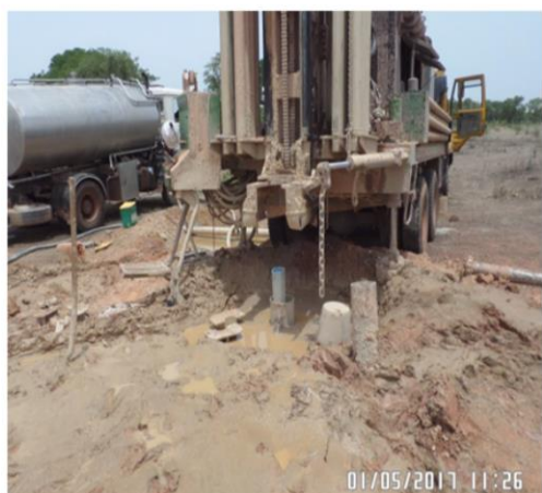
Fin travaux d'équipement du forage F2
