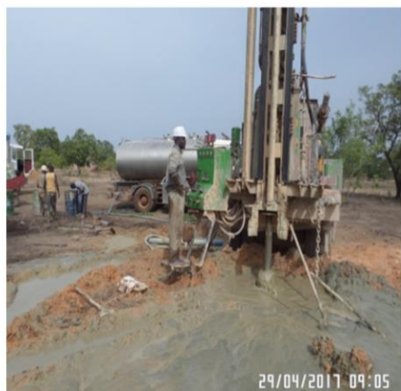
Foration en cours de F 1
