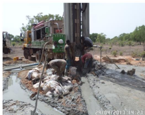
Mis en place du massif filtrant en cours F 1
