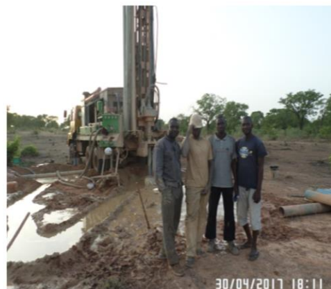
Foration en cours du forage F2
