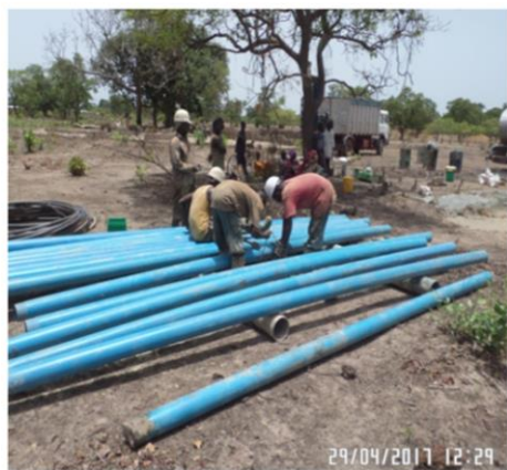
Préparatif de l'équipement du forage
