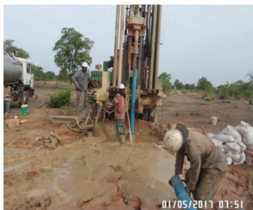
Equipement en cours du forage F2
