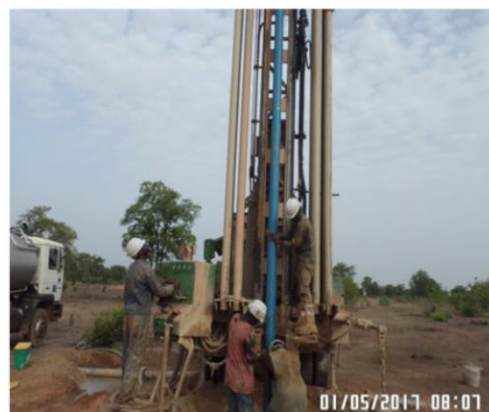
Equipement en cours du forage F2
