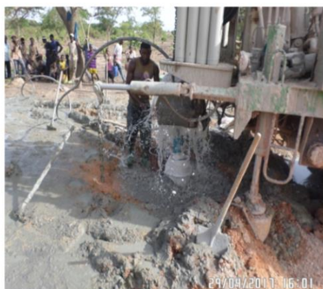
Développement du forage en cours
