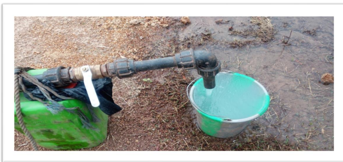
Pompage d'essai en cours à Kanso
